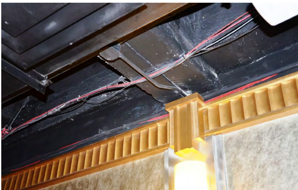
Fig. 5 – instalação sem proteção
