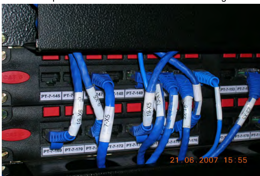
Fig. 1.2: Conexão dos cordões UTP no rack
