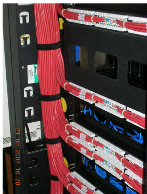
Fig. 1.3: Organização dos cordões UTP no rack
