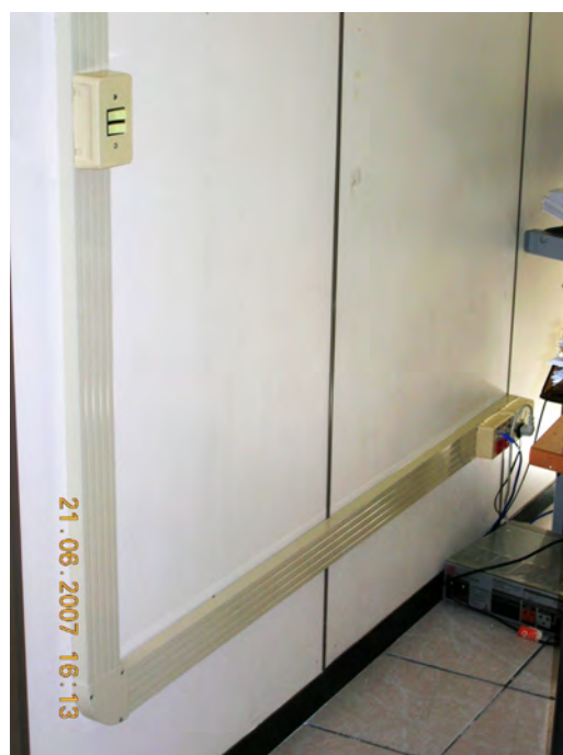
Fig. 2.2: Canaletas Dutotec, interruptores e caixa de tomadas (elétrica e lógica).
