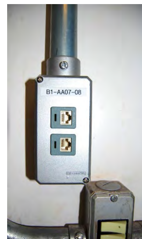
Fig. 4.4: Terminação de usuário: em divisória e na parede com caixa metálica
