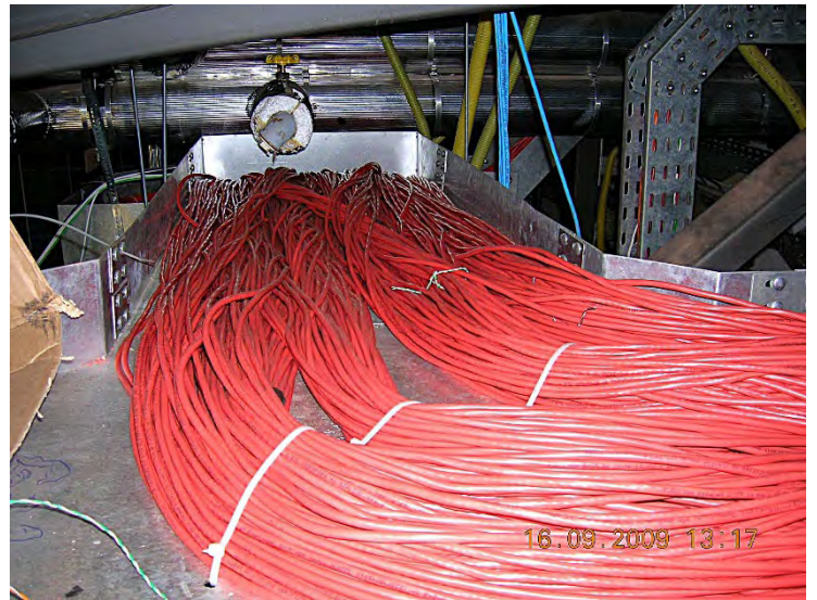
Fig. 0.13: cabos lançados no forro
