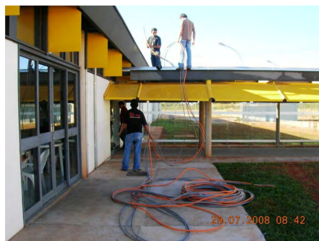
Fig. 6.10: Lançamento do backbone externo: fibra óptica e cabo CI
