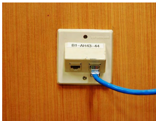
Fig. 4.4: Terminação de usuário: em divisória e na parede com caixa metálica
