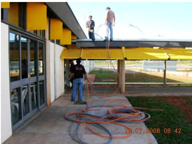
Fig. 0.4: Lançamento dos cabos ópticos
