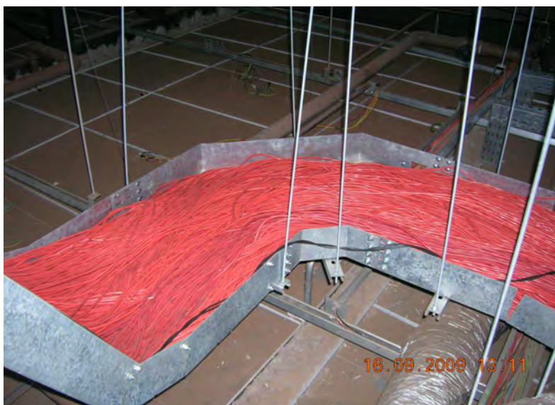
Fig. 5.2: Eletrocalhas Lisas
