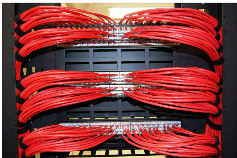
Fig. 4.8: Conectorização dos cabos horizontais no rack
