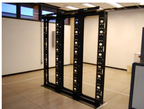
Fig. 2.4: Racks Abertos da nova instalação
