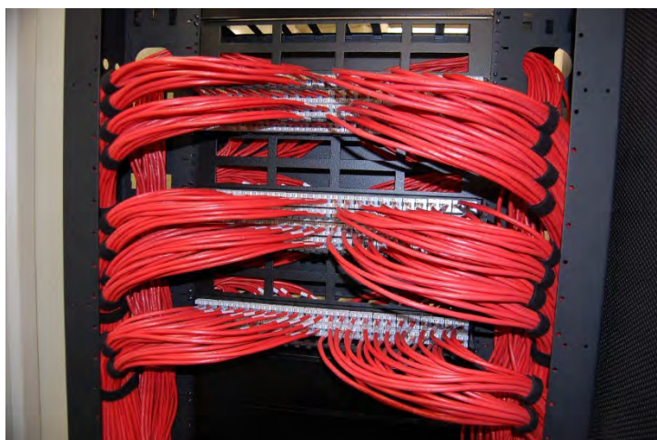
Fig. 4.10: Detalhe da acomodação dos organizadores 2U
