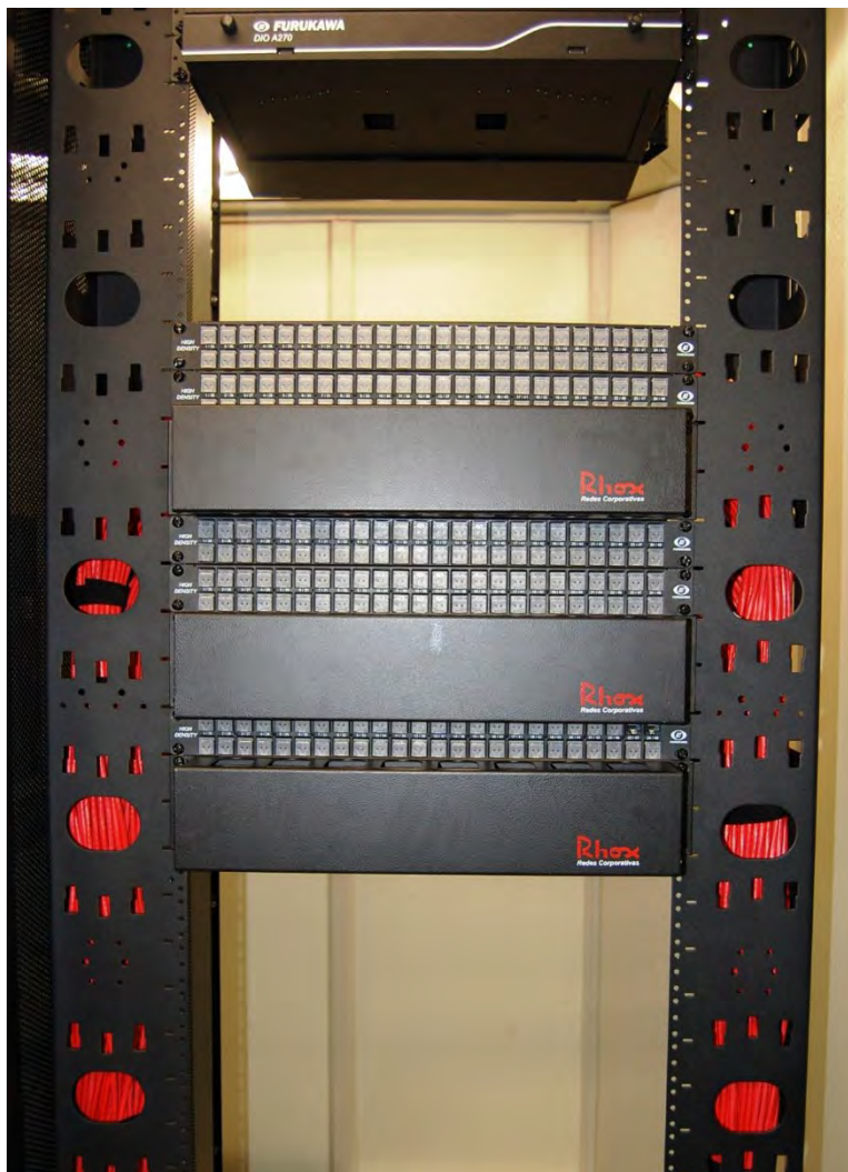
Fig. 4.19: Rack da TR (ER) antes da inserção dos cordões de manobra
