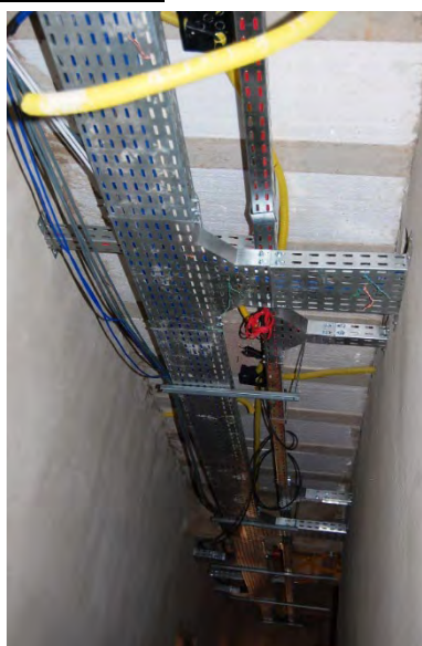
Fig. 14: eletrocalhas
