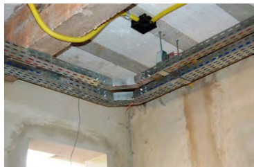
Fig. 18: Eletrocalhas
