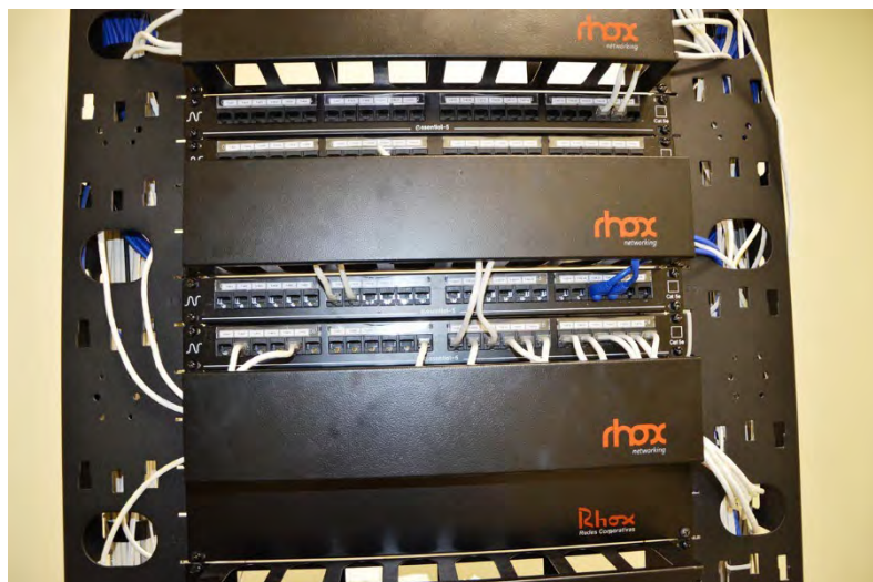
Fig. 9: vista frontal do rack – painéis de manobra UTP
