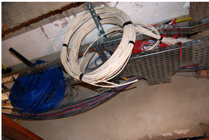
Fig. 16: Lançamento dos cabos
