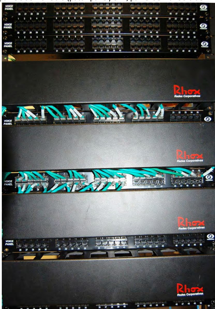
Fig. 8: organizadores de cabos no rack
