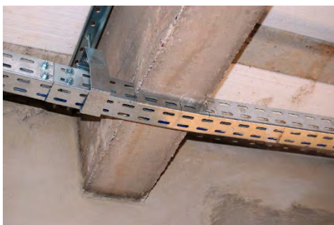
Fig. 20: Eletrocalha recrtada
