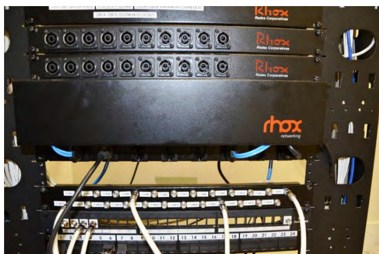
Fig. 10: vista frontal do rack – Painéis de manobra de vídeo
