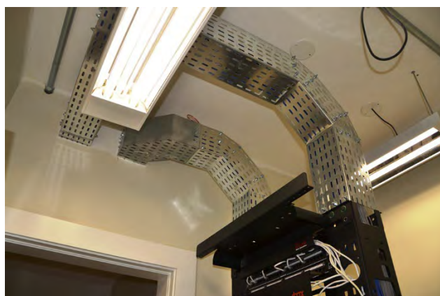
Fig. 11: acoplamento das eletrocalhas ao rack
