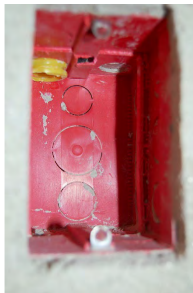
Fig 21: Caixa 4x2 com dupla profundidade (0LDP)
