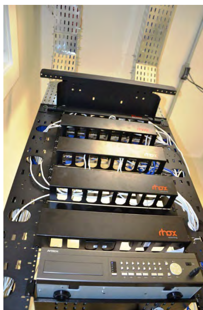
Fig. 13: Vista frontal do rack e acoplamento das eletrocalhas de encaminhamento de cabos
