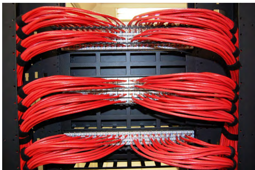
Fig. 7: Conectorização dos cabos horizontais no rack
