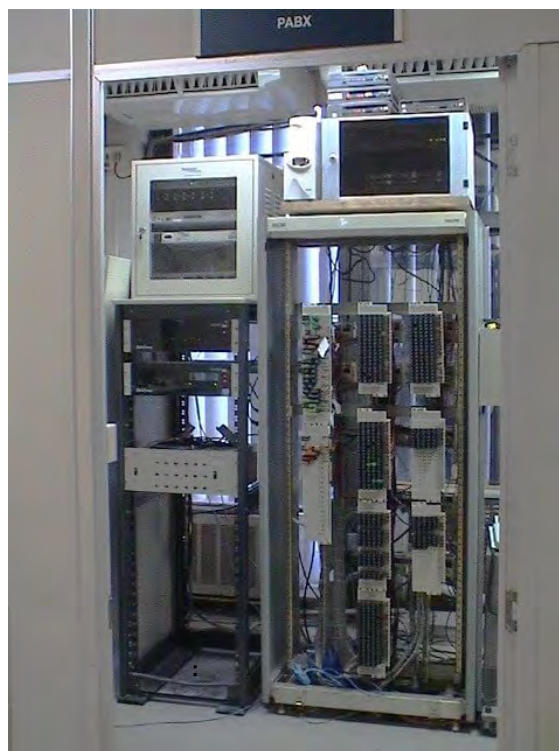
Fig. 2.2: Distribuição de telefonia
