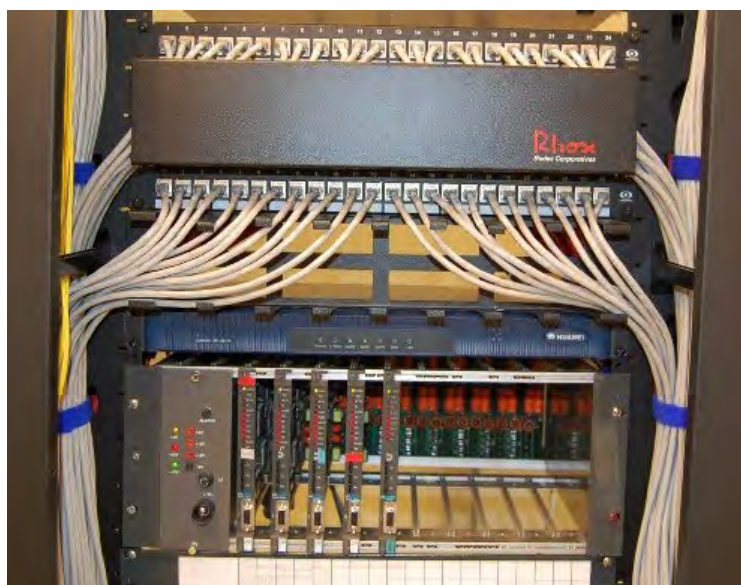
Fig. 7.7: Manobra do cabeamento blindado
