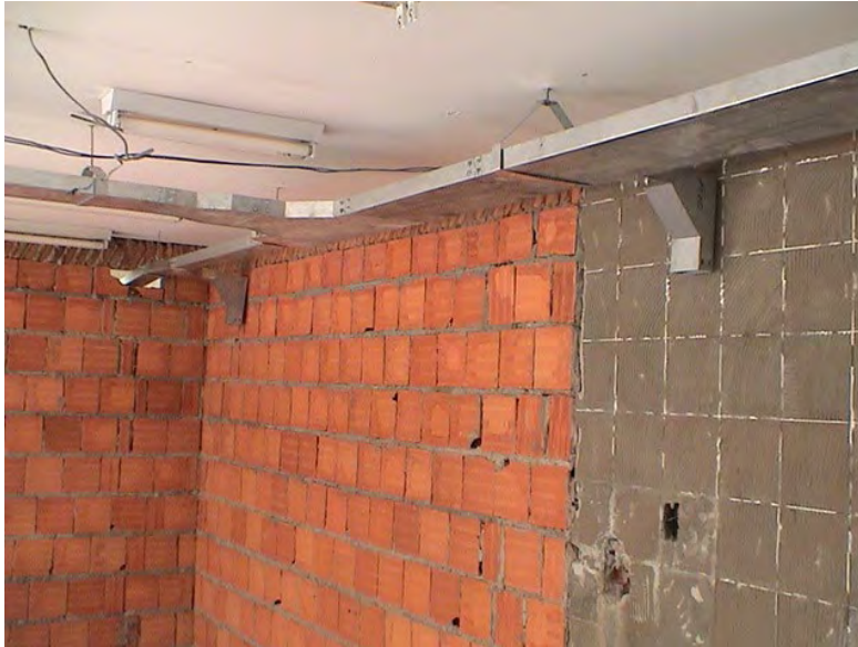
Fig. 4.1: Eletrocalhas aparentes
