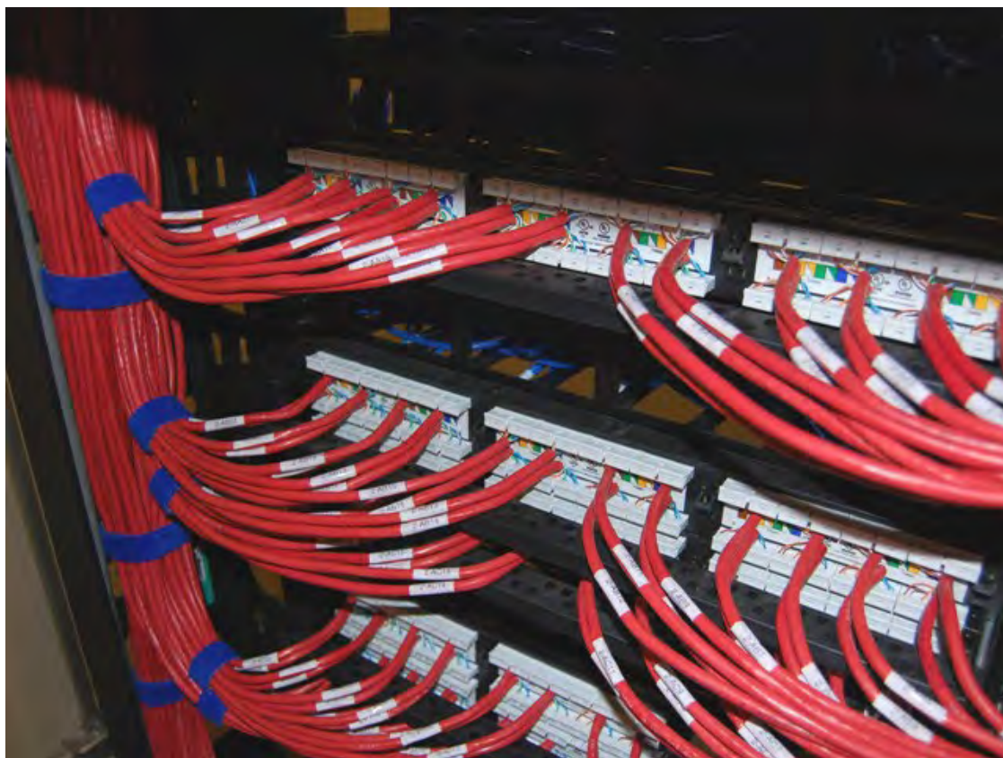
Fig. 3.5: Chegada e conectorização dos cabos nos painéis de manobra dos racks
