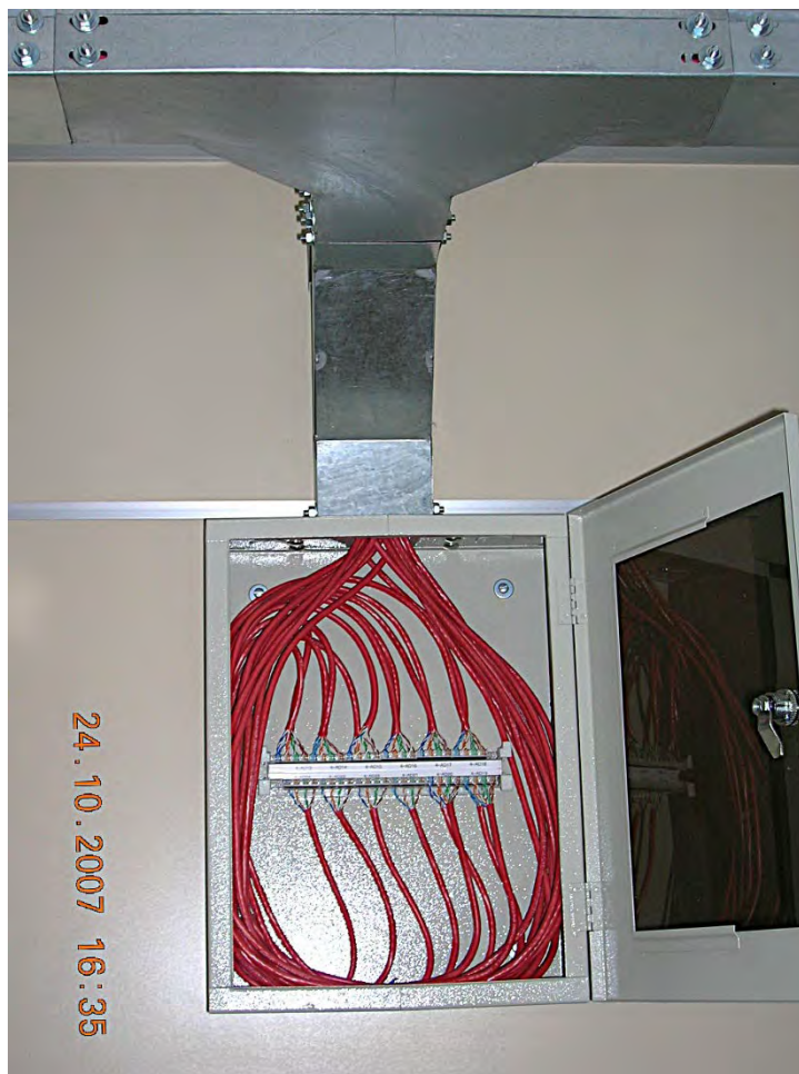
Fig. 4.3: Chegada da eletrocalha na caixa de consolidação
