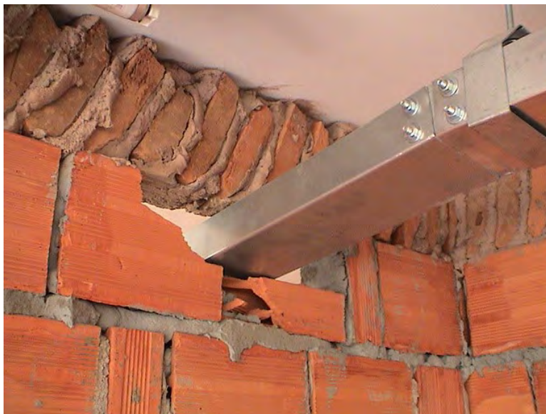
Fig. 4.2: Detalhe da passagem entre ambientes antes do acabamento da alvenaria
