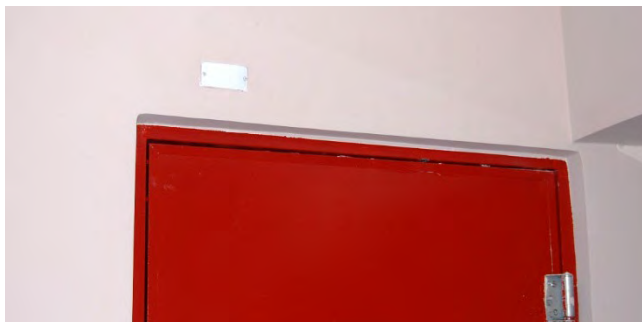
Fig. 5.20: sensor de abertura de porta
