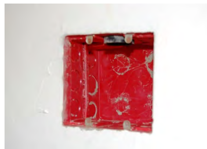
Fig. 4.31: caixa de terminação
