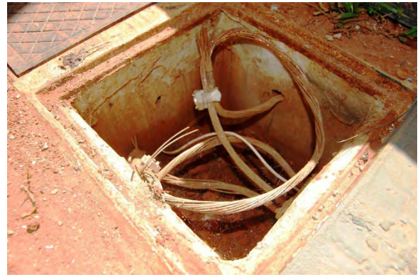
Fig. 5.27: detalhe da caixa de inspeção
