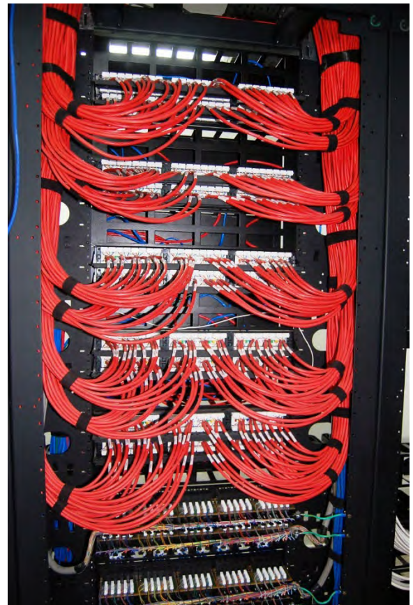
Fig. 4.15: Conectorização horizontal
