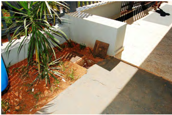
Fig. 5.26: caixa de inspeção - vista geral
