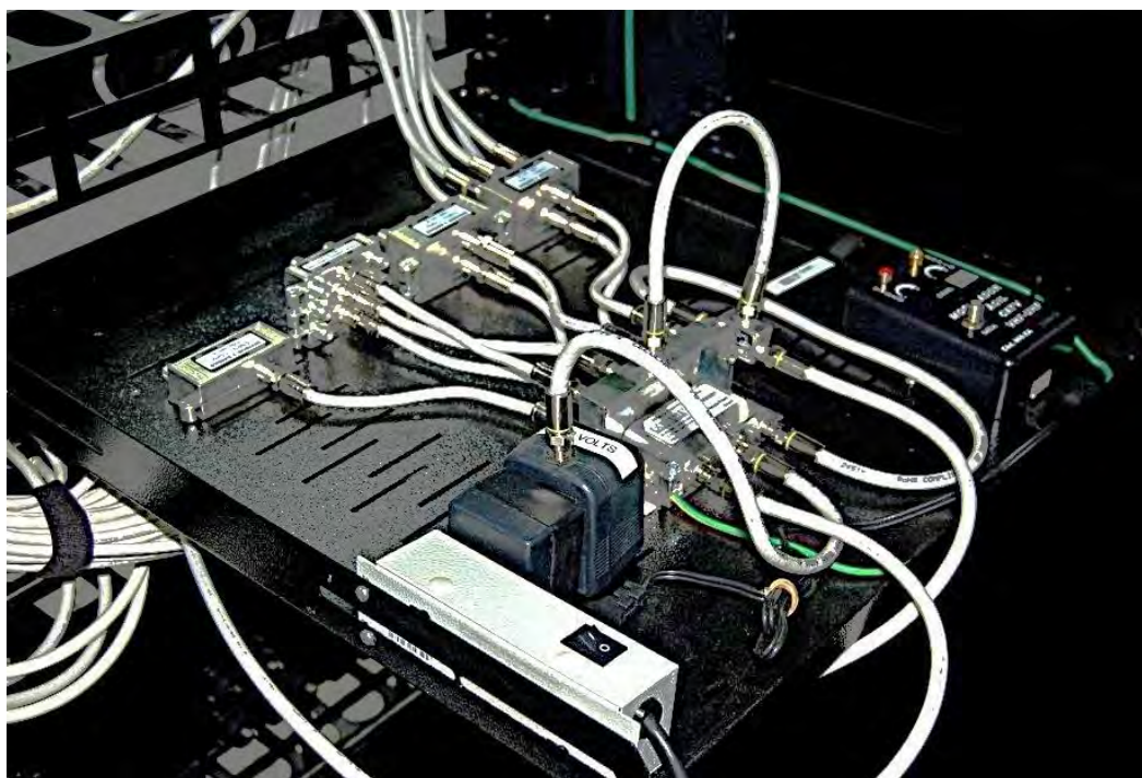
Fig 5.10: bandeja CATV no rack após instalação
