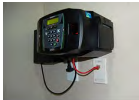
Fig. 5.8: Terminação de usuário utilizada por um relógio de ponto
