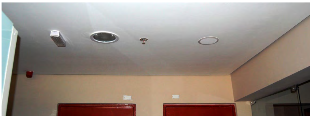
Fig 5.14: sonofletores no forro
