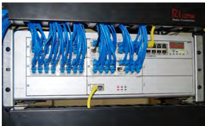
Fig. 2.9: PABX instalado
